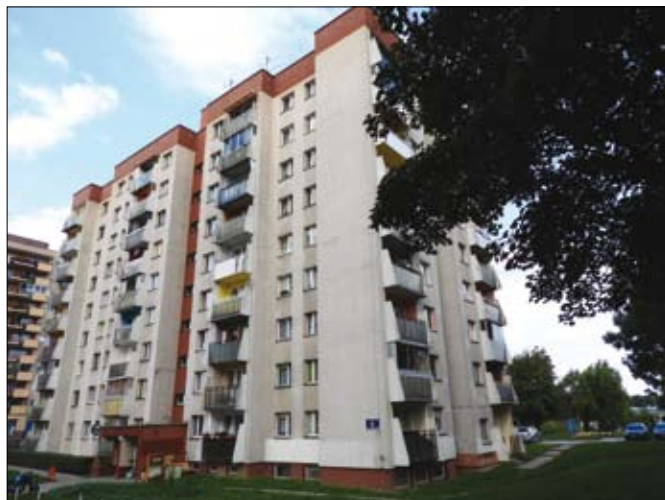
W wieżowcu przy ul. Kombatantów 6 w Krakowie jest już ciepła woda bez piecyka Zdjęcie Adam Skup/IN PLUS
