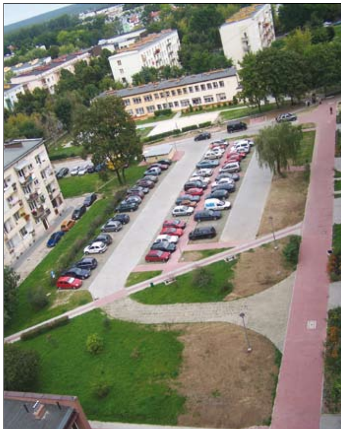
Miejsca parkingowe i ciągi piesze przy ul. Nowowiejskiej 5
