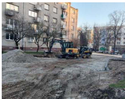
Budowa skweru i drogi p.poż. między budynkami Zagórska 43 - 45
