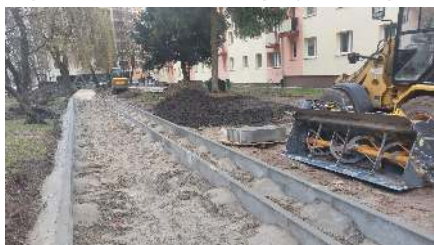
Prace budowlane przy ul. Wiosennej
