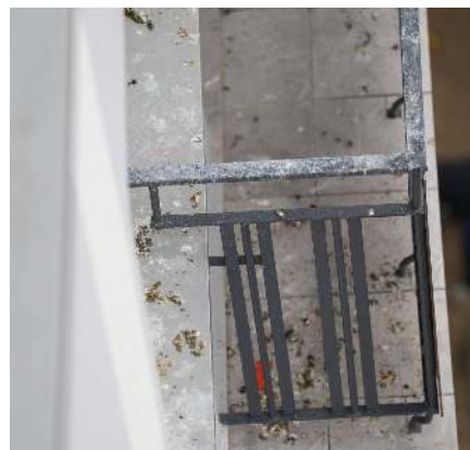
Nowe wyremontowane balkony przy ul. Szczecińskiej 3
