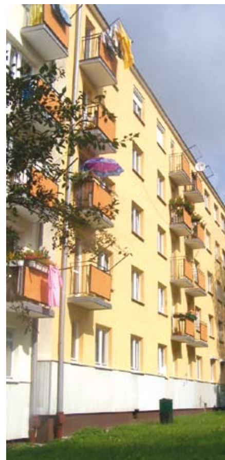
Nowa elewacja w budynku przy ul. Wiosennej 2
