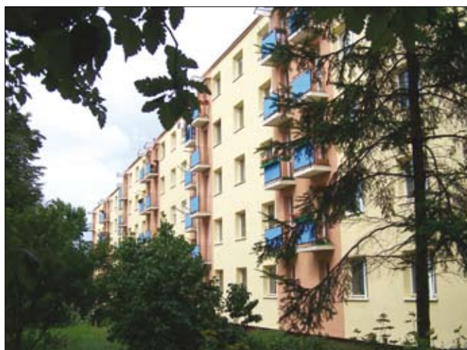
Nowa elewacja w budynku przy ul. Wiosennej 5
