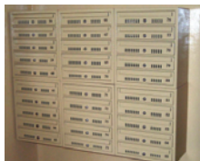
Stare i nowe skrzynki przy ul. Mazurskiej 64
