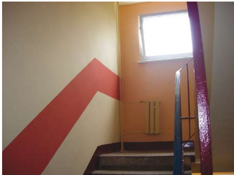
Odnowiono 43 klatki w 7 budynkach
