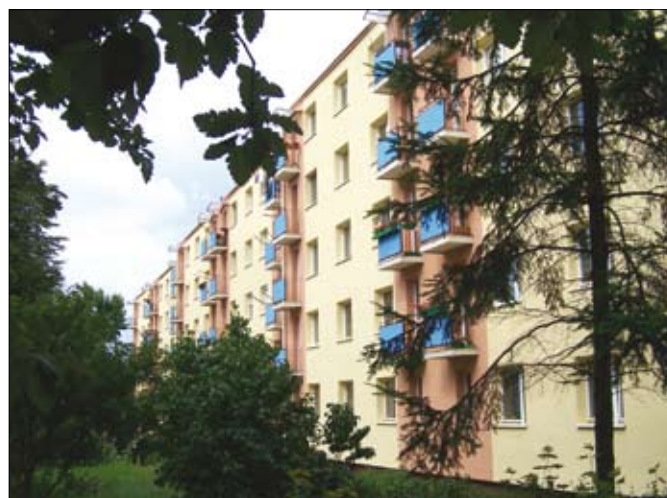
Nowa elewacja w budynku przy ul. Wiosennej 5
